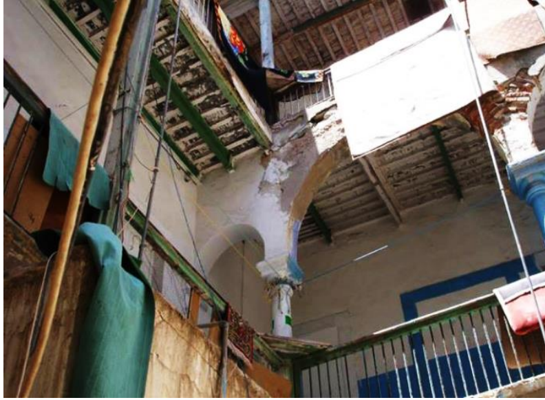
الصورة رقم 7: سقف لسكن (دار الطرابلسي بجهة "المنزل" بمدينة قابس).
